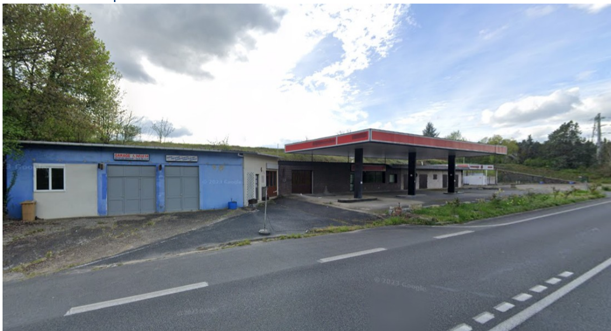
Figure 2. Ancienne station-service Esso située au lieu-dit Les Justices, D943
